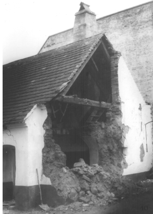
Schäden in Schwadorf im Jahr 1927
